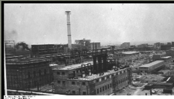
Budowa zakładów chemicznych IG Farben ( Interessen-Gemeinschaft Farbenindustrie AG ) w Monowicach 1941r.
